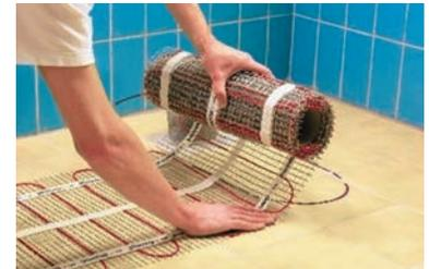
3. У противоположной стены или при обходе места установки стационарного оборудования сетку мата разрезать, и мат повернуть вокруг кабеля в нужном направлении.
